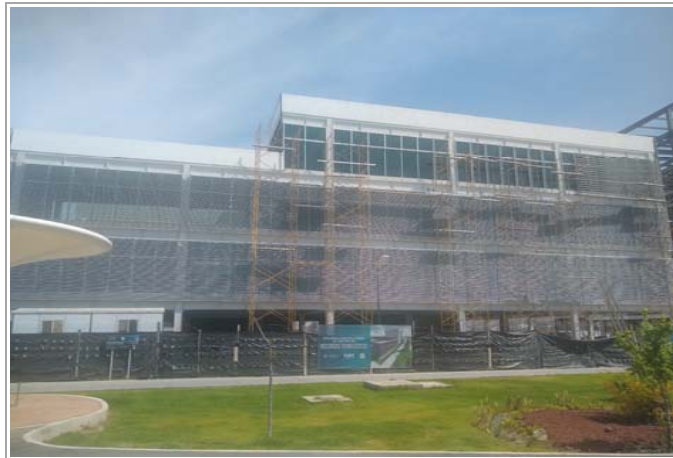
F1: Fachada principal
