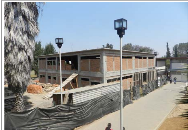
F1: Fachada principal
