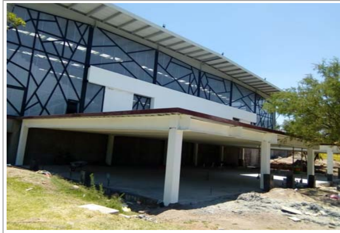
F1: Fachada principal
