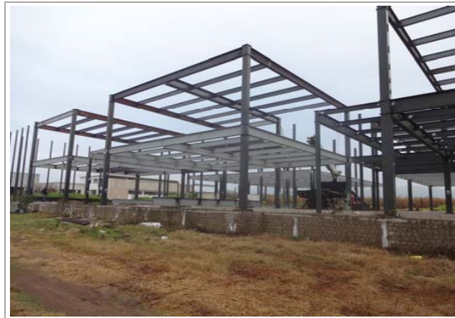
F1: Fachada principal
