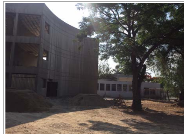
F1: Fachada principal
