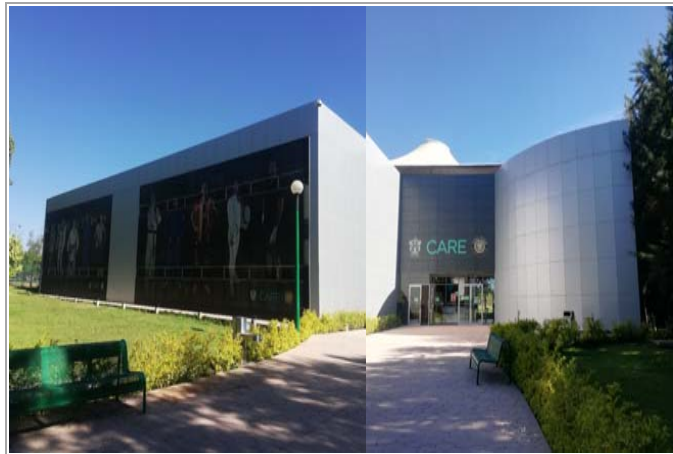
F1: Fachada principal
