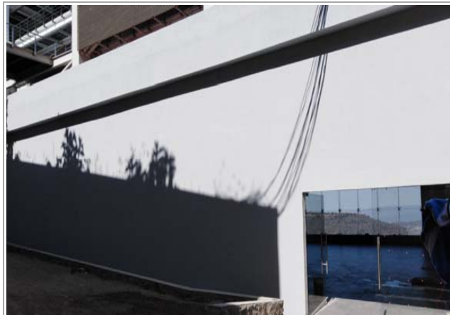
F1: Fachada principal
