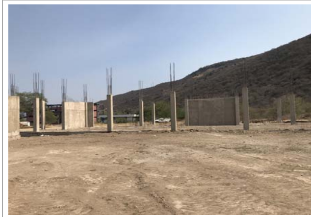
F1: Fachada principal
